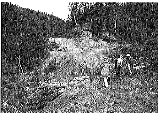
写真8 沢に丸太を渡した仮橋。ここは決壊しており、別の林道にルートを探しに引き返した。ネルピチャ川流域
